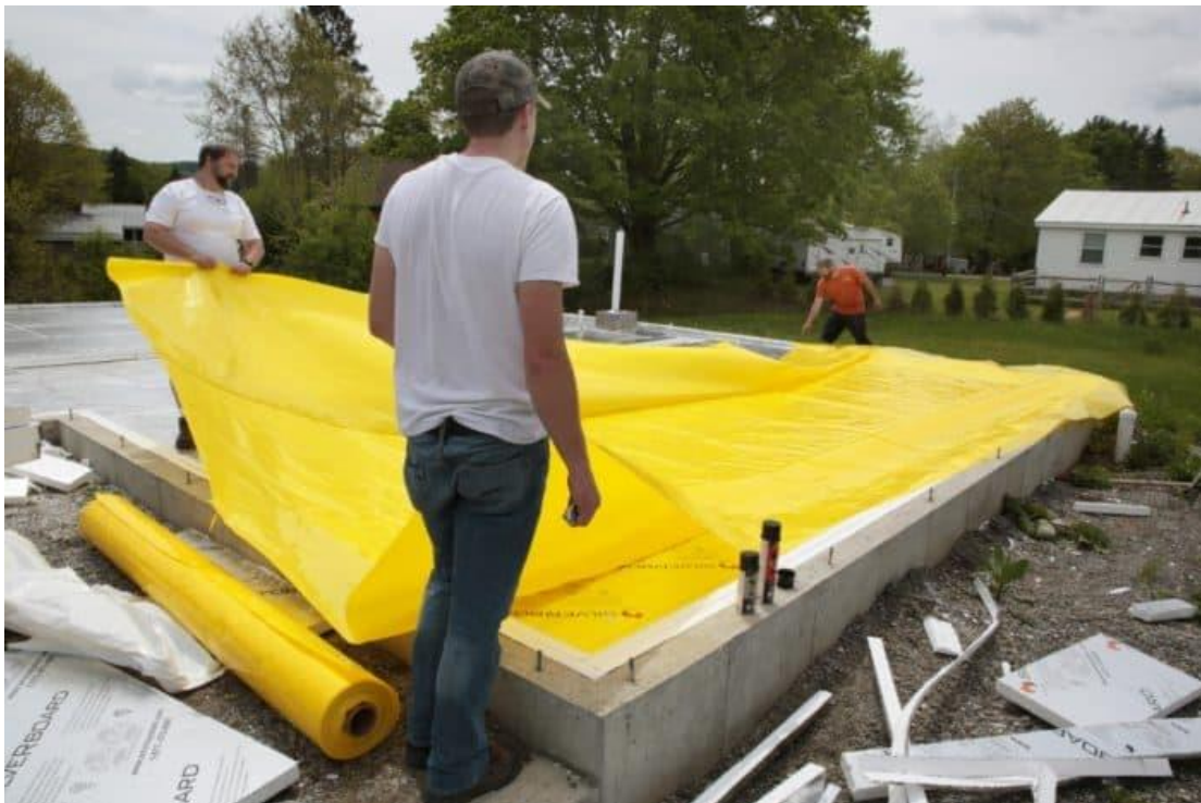
The Stego Wrap rolls vapor barrier 20 mil
